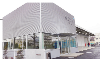
3月に開設した羽村サービスセンター
