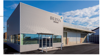
Nearly ZEB認証を取得した筑西サービスセンター
